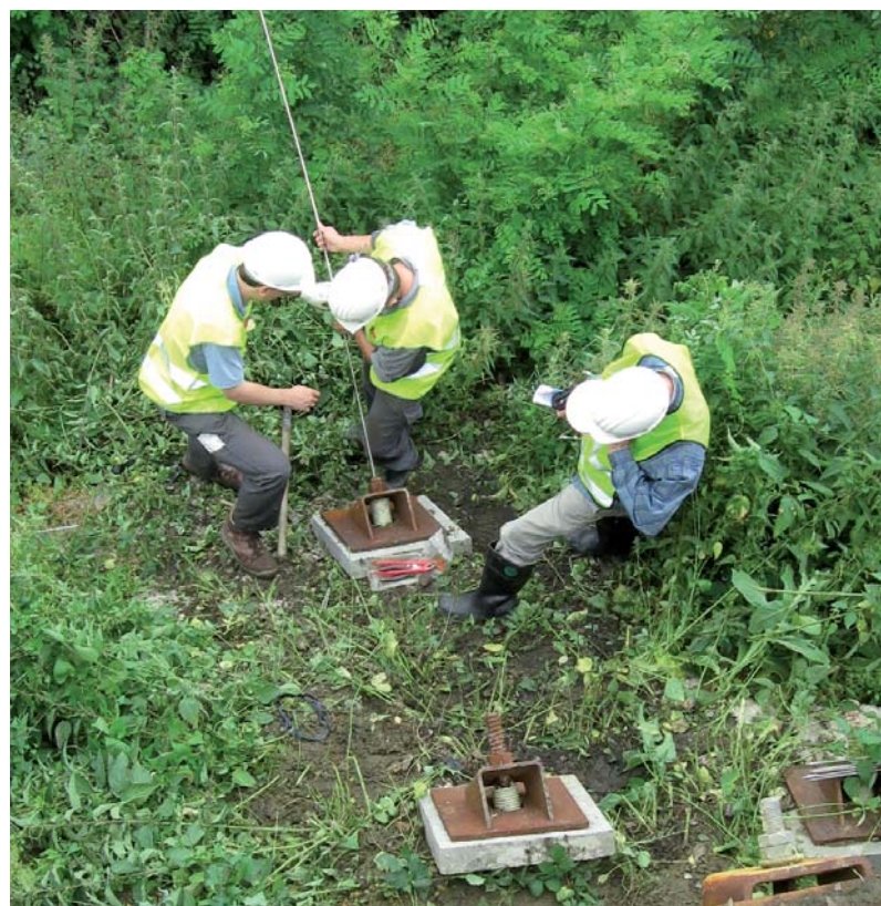
Figuur 9 Installatie van optische vezel en injectiesysteem in een jet-grout nagel te Ottignies.
