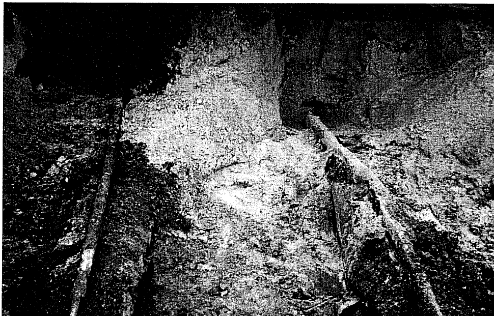
Figuur 6b : Vrijgegraven nagels 3 en 4
