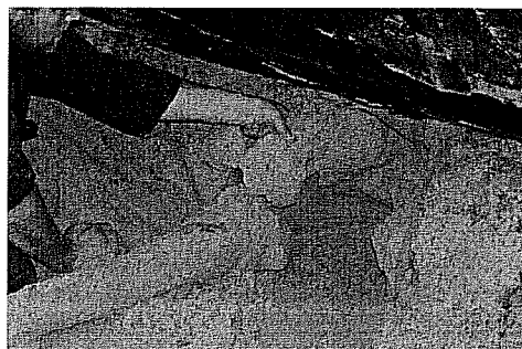
Figuur 8f: Cementprop bij nagel 4
