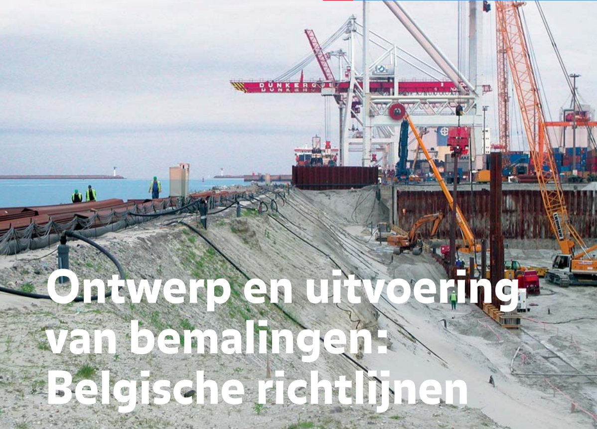
Figuur 1 Voorbeeld van een bemalingsinstallatie.
